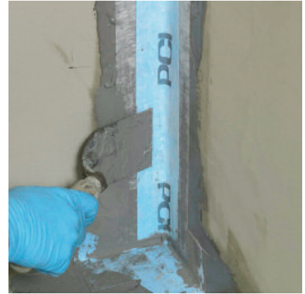
Die Dichtbänder PCI Pecitape in die Eckverbindung eindichten.
