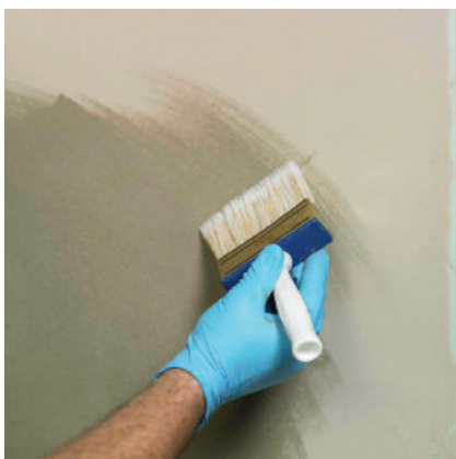
Untergrund mattfeucht vorbereiten.
