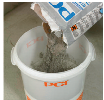
PCI Seccoral 2K Rapid Pulver dazugeben.
