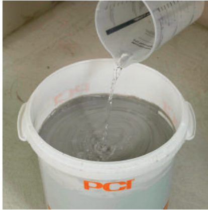
Für das Streichverfahren (1 b) entsprechend Wasser hinzugeben.
