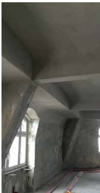
Decke und Unterzüge | gefilzte Oberfläche
