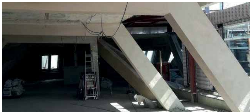
Stahltragwerke als Designelement
