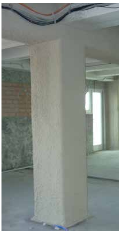
Betonstütze spritzrau
