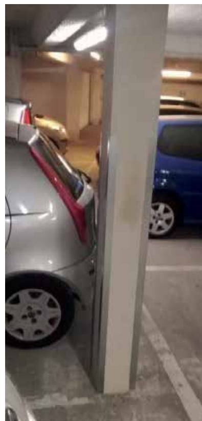
Stahlstütze mit Kantenschutzprofil
