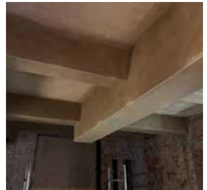
Kastenförmige Bekleidung von Deckenträgern
