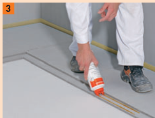
3 Im Falzbereich der Elemente den FERMACELL Estrich-Kleber auftragen
