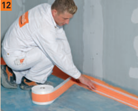
12 In die feuchte Flüssigfolie FERMACELL Dichtband eindrücken
