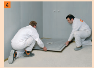
4 Variante 1b: Man zieht in Höhe der Oberkante des Ablaufgehäuses die gesamte Fläche mit der gebundenen Schüttung ab und setzt das Duschelement
