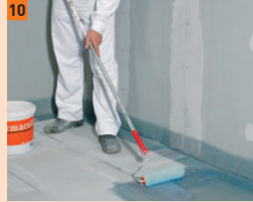
10 ... dann im Bodenbereich per Rolle auftragen
