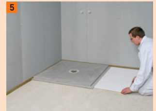
5 Variante 1b: Um auf die Höhe des Stufenfalzes vom Duschelement zu kommen, wird über die Fläche 10 mm dicker Dämmstoff (EPS DEO 150) verlegt
