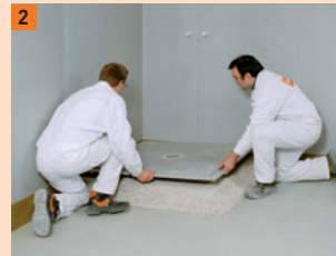
2 Variante 1a: In der Höhe der Oberkante des Ablaufgehäuses wird im Bereich des Duschelements die gebundene Schüttung abgezogen und das Duschelement gesetzt
