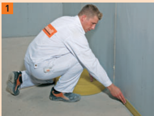
1 Randdämmstreifen verlegen
