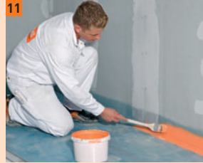
11 FERMACELL Flüssigfolie mit dem Pinsel in die Ecke auftragen
