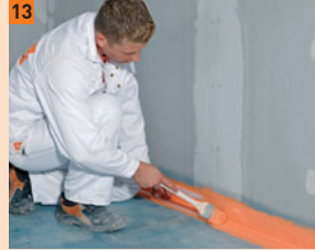
13 Im 2. Arbeitsgang das Dichtband mit FERMACELL Flüssigfolie überstreichen
