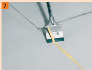
7 Ausgetretenen Estrich-Kleber nach dem Aushärten abstoßen
