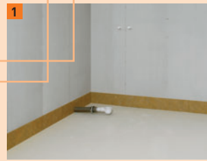
1 Nachdem die Lage des Duschelements markiert ist, wird das Ablaufgehäuse gesetzt
