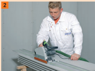
2 Für die erste Reihe den Falz abschneiden
