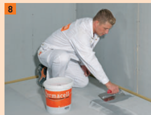
8 Bei Bedarf Stoßfugen und Verbindungsmittel abspachteln
