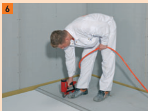
6 ... oder 22 mm Spreizklammern
