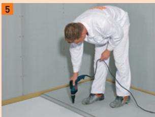
5 Verbindungsmittel: Powerpanel TE Schrauben...
