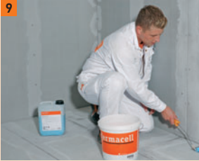
9 FERMACELL Voranstrich erst im angrenzenden Wandbereich...
