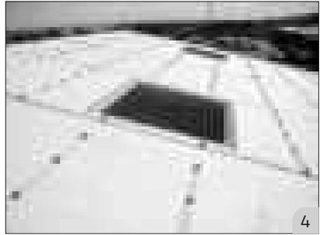
Abb. 4: Werkseitig eingebaute Durchsturz-sicherung
