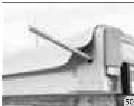
Abb. 50: Spannsteel eingefädelt
