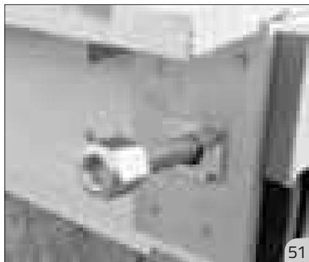
Abb. 51: Spannstahl mit Kopfplatte und Mutter
