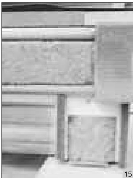
Abb. 15: Ausgedämmtes Übergangselement im Auflagerbereich mit Befestigungswinkel
