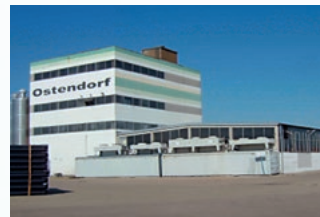
Werk Rain am Lech
