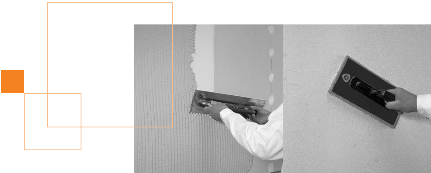
Bild 3.16: Aufbringen des FERMACELL Leichtmörtels HD
