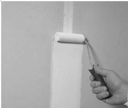
Bild 3.14: Aufrollen des FERMACELL Armierungsklebers HD
