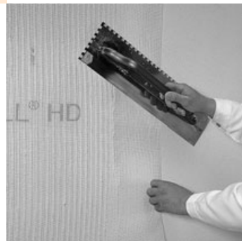
Bild 3.20: Überlappung des Armierungsgewebes mit ca. 10 cm
