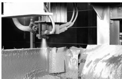
Bild 1.2: Aufspritzen der unteren Deckschicht
