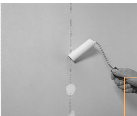
Bild 3.15: Deckendes Abtupfen der Verbindungs- mittel in Plattenmitte
