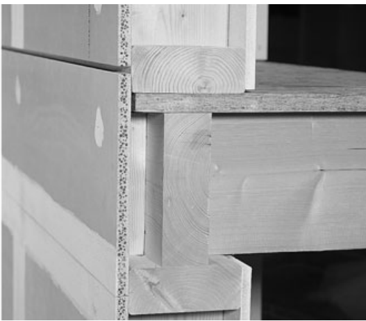
Bild 4.12: Mit HD-Fugentechnik versehener Bereich des Plattenstreifens
