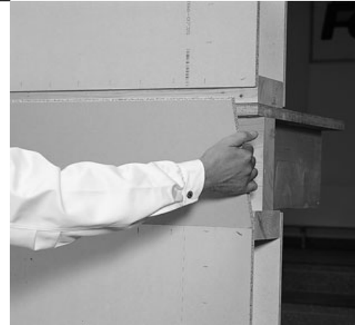
Bild 4.11: Montage des Plattenstreifens
