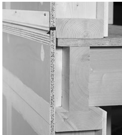
Bild 4.15: Fertig montierter Platten- streifen mit FERMACELL Deckenstoßprofil HD
