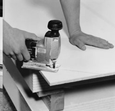
Bild 3.4: Einsatz einer Stichsäge für Rundungen und Anpassungen
