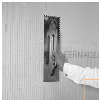
Bild 3.19: Eindrücken des FERMACELL Armierungsgewebes HD in das Mörtelbett
