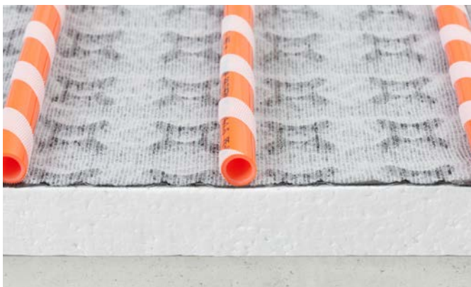
Abb. 4-46 Fußbodenaufbau mit zusätzlicher Wärmedämmung
