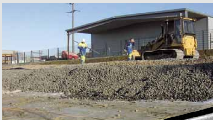
STABILISIERUNG EINER PARKFLÄCHE mehrlagiger Einbau von GEOCELL® Schaumglas- schotter als lastverteilende Schicht (1,80 m)
