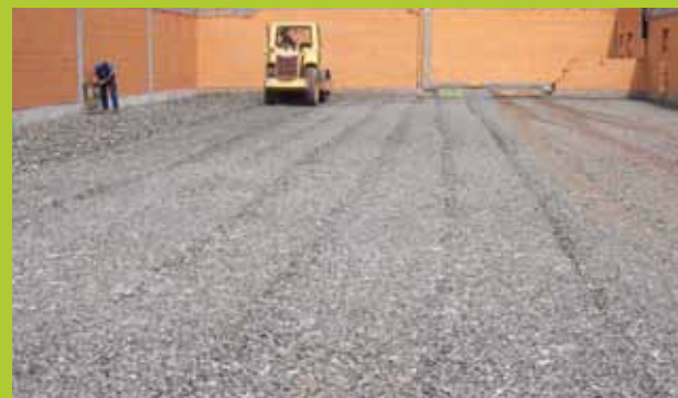
KAPILLARBRECHEND: ersetzt die kapillarbrechende Schicht
