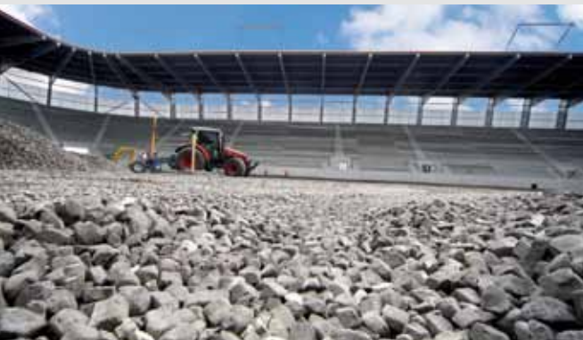
AFG FUSSBALLARENA ST. GALLEN, SCHWEIZ GEOCELL® im Einsatz als leichte, drainagefähige Dämm- schüttung unter dem Fussballrasen
