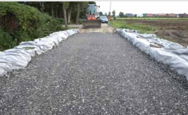
STRASSENBAU, EDEWECHT, DEUTSCHLAND: landwirtschaftliche Zufahrtsstraße auf schlecht tragfähigem Boden
