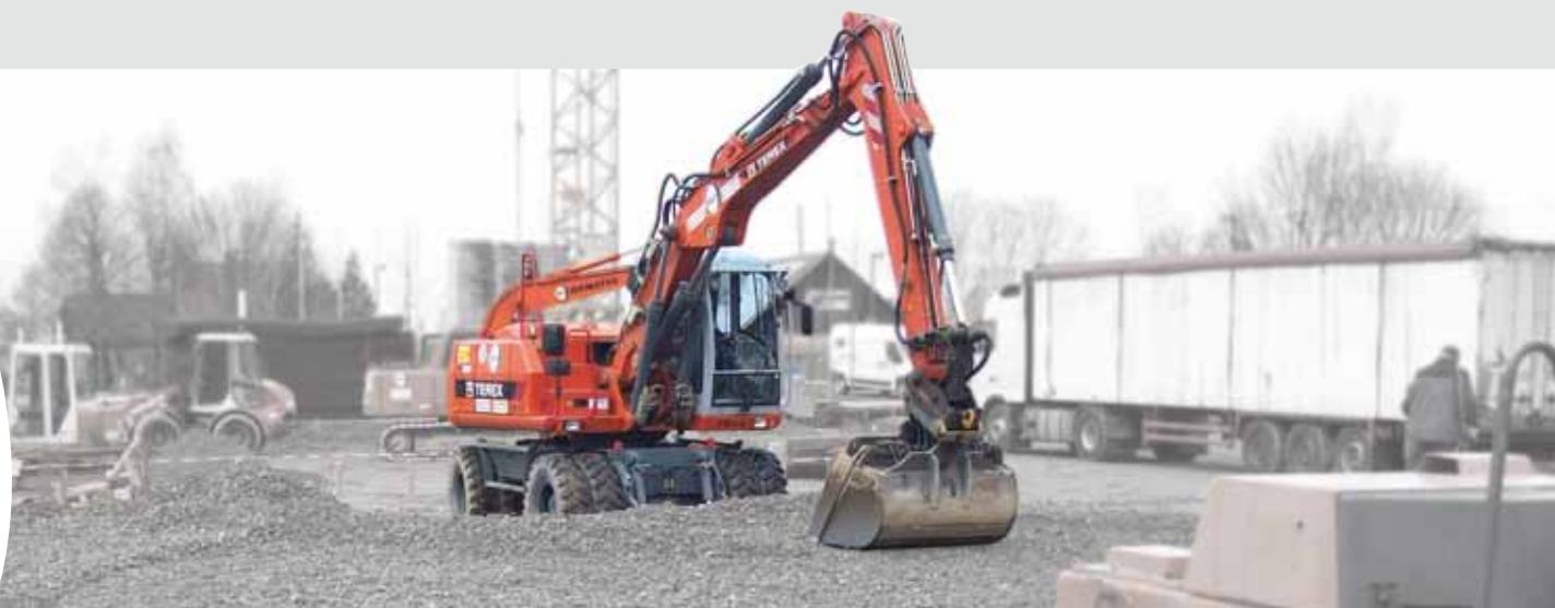
Großflächiger Einbau von GEOCELL® für eine Produktionshalle
