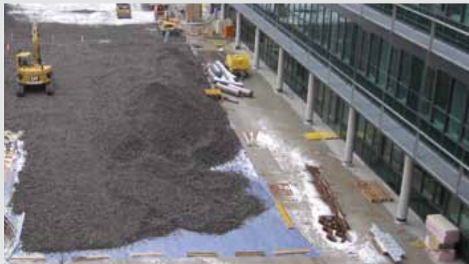
TECHNISCHE UNIVERSITÄT WIEN, ÖSTERREICH: befahrbare Überdämmung einer Tiefgarage
