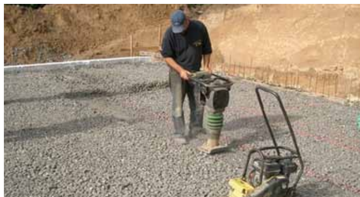
erreicht man mit einem Stampfer, Vorbereitung für Gründungspolster
