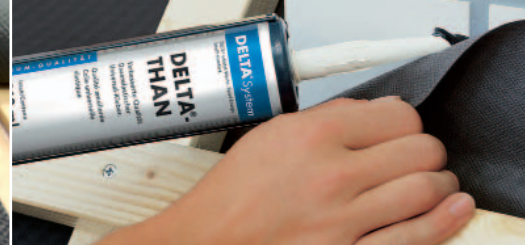
Sichere Verklebung im Anschlussbereich mit DELTA®-THAN.
