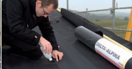
Sichere Abdichtung mit DELTA®-QUELLSCHWEISSMITTEL. Schnelle Montage der Traglattung.
