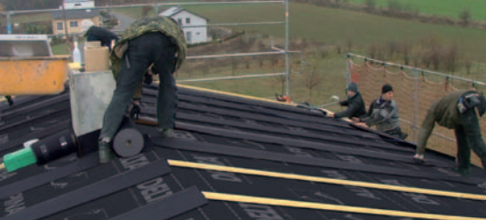
Einfache Montage von DELTA®-ALPINA BAND.
