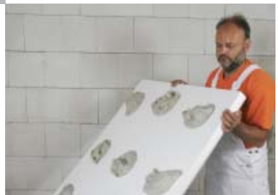
Verbund-Platten sind mit Dämmstoff kaschirt
