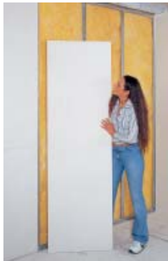
Die „schlanke“ FERMACELL Platte ist 625 mm breit
