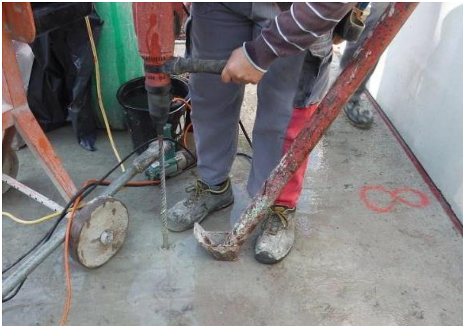
Schrägstütze mittels Gestellschrauben an Wand befestigen, die Montagedübel sind im Element bereits werkseitig eingebaut
