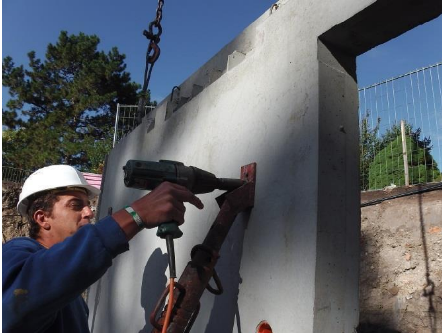
Schrägstütze mittels Gestellschrauben an Wand befestigen, die Montagedübel sind im Element bereits werkseitig eingebaut
