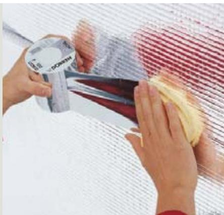
Aluminiumbedampftes, reißfestes Klebeband. Hochalterungsbeständig. Hohe Klebekraft.
