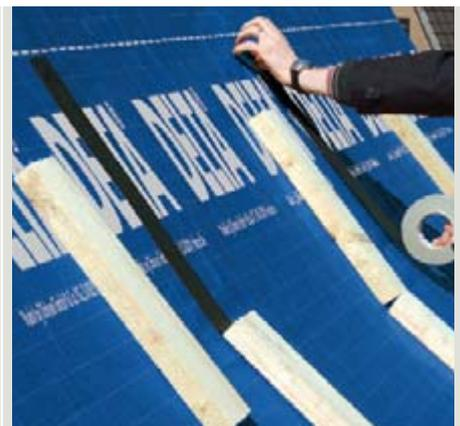
Doppelseitig klebendes Dichtband aus Bitumen-/Kautschukmasse.
