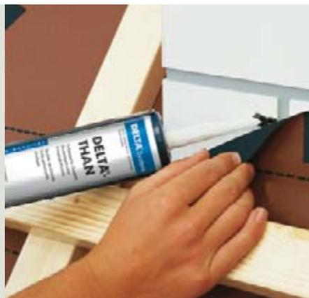
Dauerelastischer Kartuschenkleber aus Spezialkautschuk. Außen.
