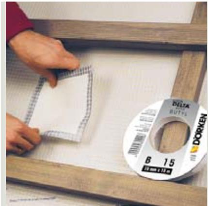
Witterungsbeständiges, armiertes, beidseitig klebendes Butylkautschukklebeband.
