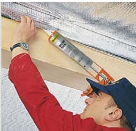
Kartuschenkleber zum luftdichten Anschluss von Dampfsperren auf Mauerwerk. Ohne Anpressleiste. Innen.
