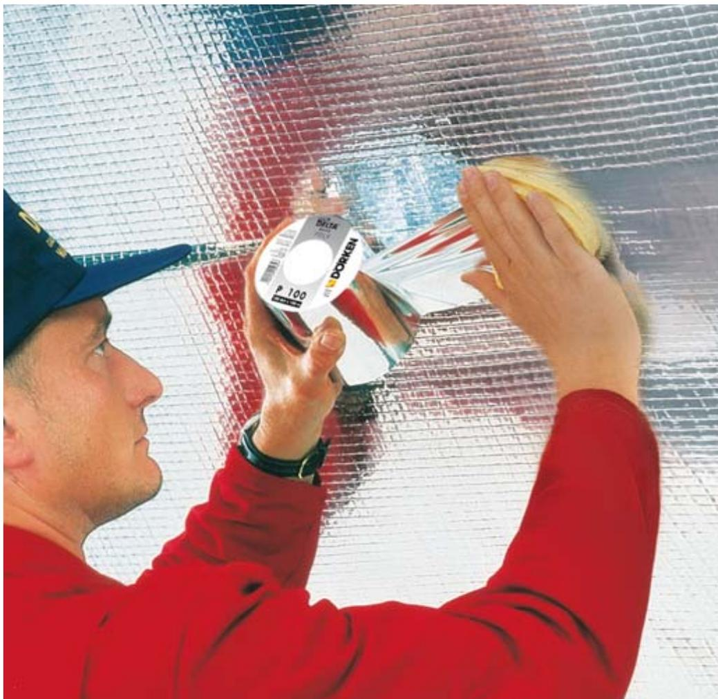
Mit DELTA®-Klebebändern können Luft- und Dampfsperren – hier DELTA®-REFLEX – leicht verarbeitet werden.
