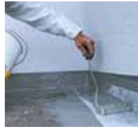
4 ... mit Triflex ProDetail satt nachlegen.
