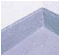
11 Der Balkon ist innerhalb eines Tages fertig.
