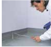
8 Die Versiegelung Triflex Cryl Finish 205 erst an den Details, ...
