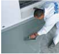
6 ... mit einer Kelle aufziehen und ...
