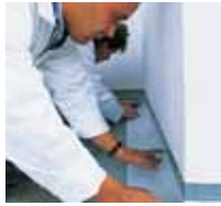
3 Triflex Spezialvlies blasenfrei einlegen und ...
