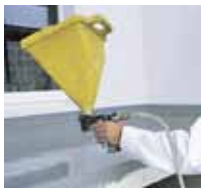
10 ... Triflex Micro Chips einblasen.
