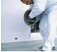
5 Die Flächenbeschichtung Triflex ProFloor ...
