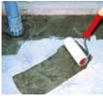
1 Wandanschluss und Fläche grundieren.
