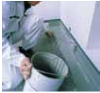
2 Anschlüsse mit Triflex ProDetail vorlegen.
