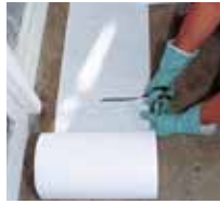
2 Triflex Spezialvlieszuschnitte vorbereiten.
