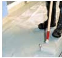
9 Eine zweite Schicht Triflex ProTerra wird aufgebracht.
