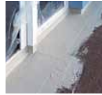
5 Eine zweite Schicht Triflex ProDetail wird aufgebracht.
