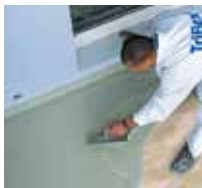
11 ... mit einer Kelle aufziehen und egalisieren.
