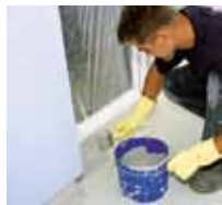
12 Die Versiegelung Triflex Cryl Finish 205 auftragen und ...
