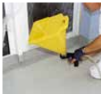
13 ... Triflex Micro Chips einblasen.
