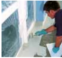
3 Zuerst werden die Details mit Triflex ProDetail abgedichtet.
