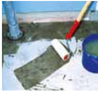
1 Wandanschluss und Fläche grundieren.
