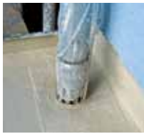
6 Die Details sind sicher abgedichtet.
