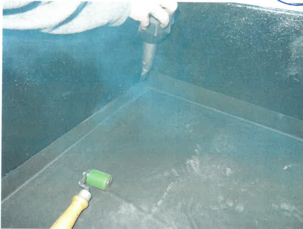
Bild 2: Verschweißen des Randes der Flächenabdichtung (exemplarisch, aus [1])
