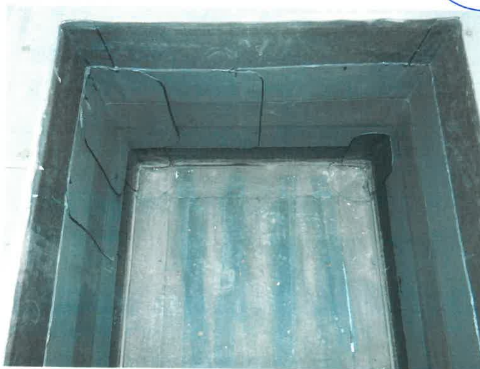
Bild 14: Abdichtung nach der Demontage der Prüfeinrichtung und dem Ablassen des Wassers
