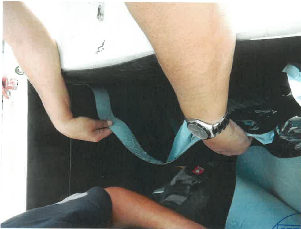
Bild 5: Verlegung des ersten Abschnittes des RESIFLEX SK Bewegungsfugenbandes
