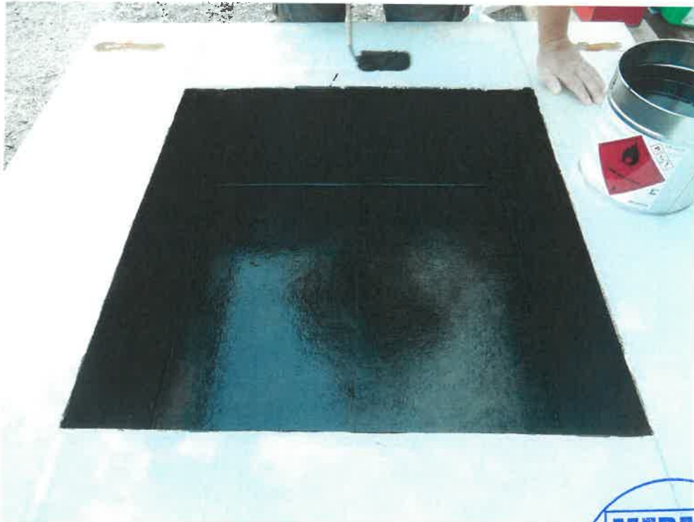
Bild 1: Grundieren der Betonoberflächen mit FG 35 Flächengrundierung
