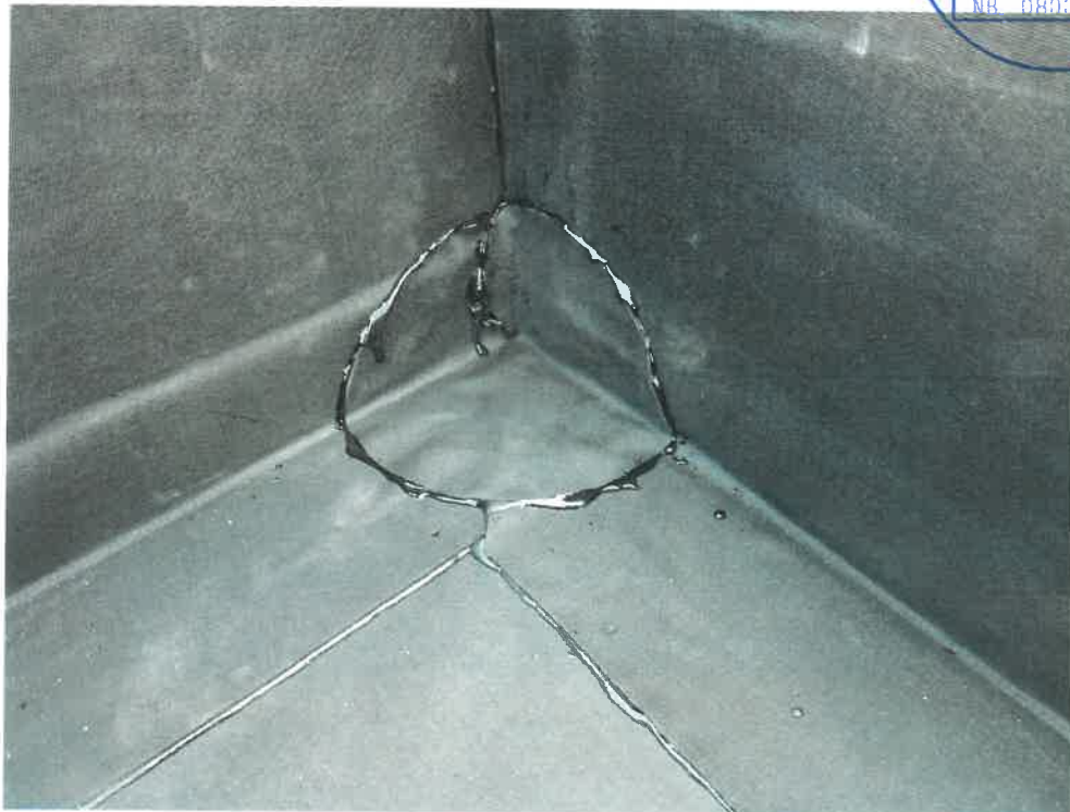
Bild 4: Applikation des kreisförmigen Abschnittes zur Sicherung der Füge-nähte in den Ecken
