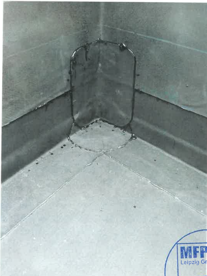
Bild 7: Sicherung des unteren Bewegungsfugen- bandrandes im Bereich der Ecke
