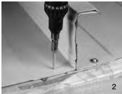
Abb.: Fixierung auf der Unterkonstruktion
