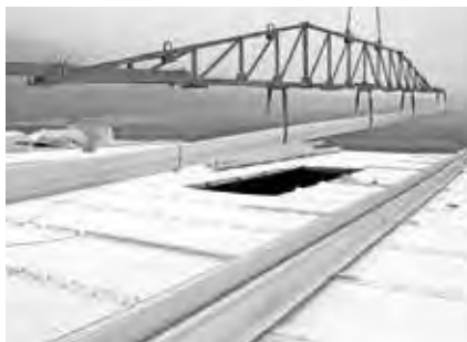
Abb.: Entladung der Domitec-Dachprofile
