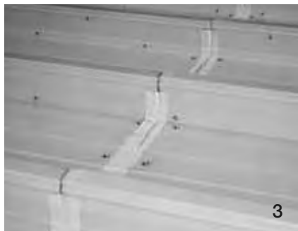
Abb.: Querstöße verklebt
