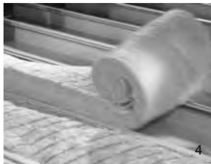
Abb.: Kassetten-Tragschale mit Wärmedämmung
