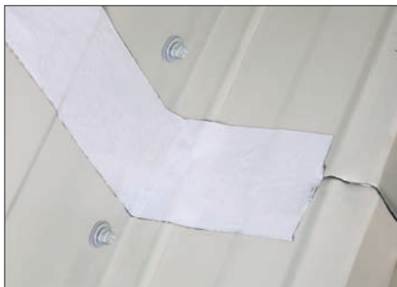
Abb. 72 Abdichten der Querstöße
