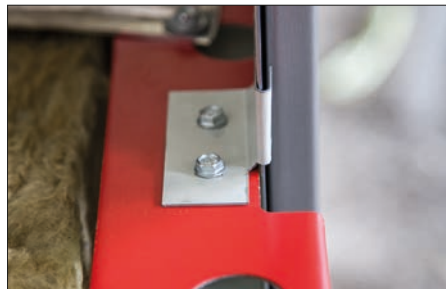
Abb. 53 Fixgleithafter Detail
