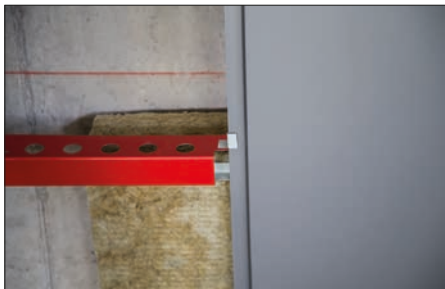
Abb. 52 Fixgleithafter
