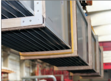
Abb. 02 Distanzholz unten im Bereich des Hebegurtes
