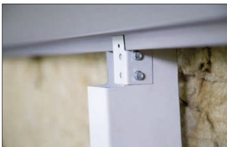
Abb. 43 Fixgleithafter: ohne Niete (äußeren)
