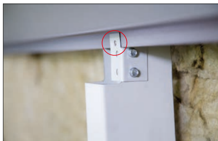
Abb. 44 Fixpunkthafter: Vernietung mit Planum-Profil (mittleren)
