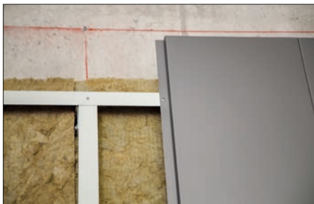
Abb. 49 Planum Profile bei senkrechter Montage
