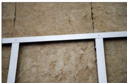
Abb. 48 Fixpunktwinkel
