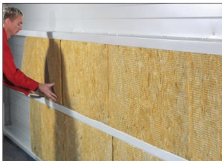
Abb. 73 Kassetten-Innenschale mit Wärmedämmung
