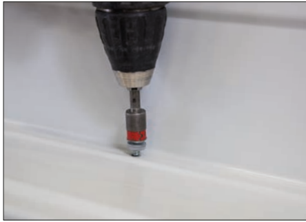
Abb. 69 Werkseitig vorgestanzte Lochung
