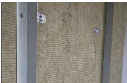
Abb. 23 Ausgleichswinkel auf Kasette mit vorgesetzter Wärmedämmung
