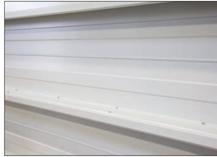
Abb. 70 Verschraubung der Kassetten
