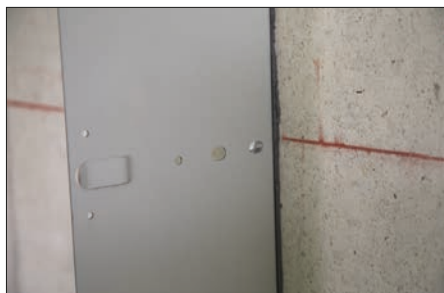
Abb. 24 Ausgleichswinkel auf Betonwand
