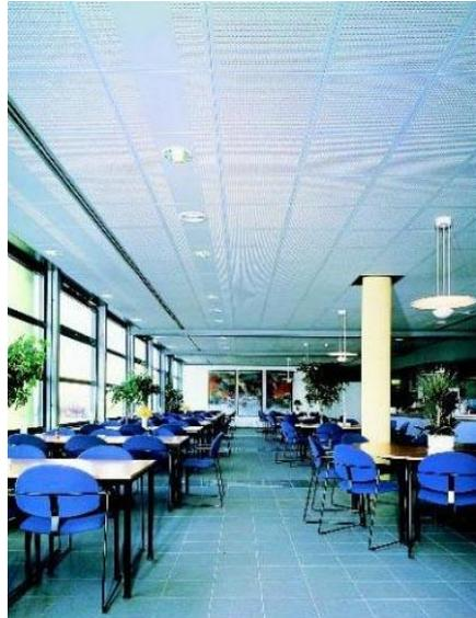
Gyptone Decken bestehen aus einer oberflächenendbehandelten 12,5 mm Gipskartonplatte mit einem rückseitig aufkaschierten weißgrauen Akustikvlies in den Abmessungen 625 x 625 mm bzw. 600 x 600 mm. (Gyptone Base hat keine Vlieskaschierung.)
