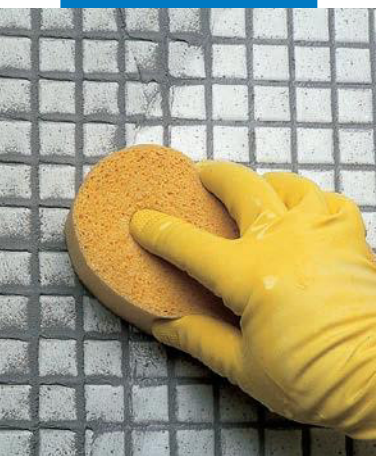
Reinigen des Glasmosaiks mit einem Schwamm
