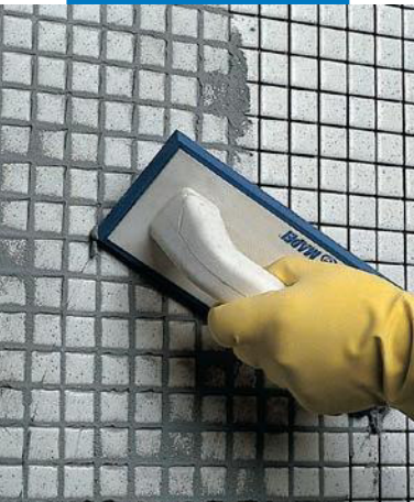
Verfugung von Glasmosaik (Badezimmer) mit einer Gummifugscheibe
