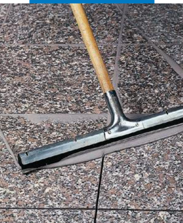
Verfugung eines polierten Granitbodens mit einem Gummiwischer
