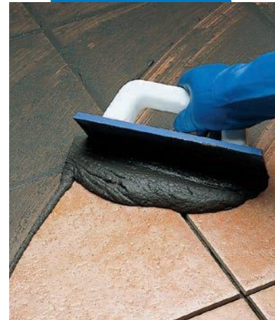
Verfugung einer Keramik mit einer Gummifugscheibe
