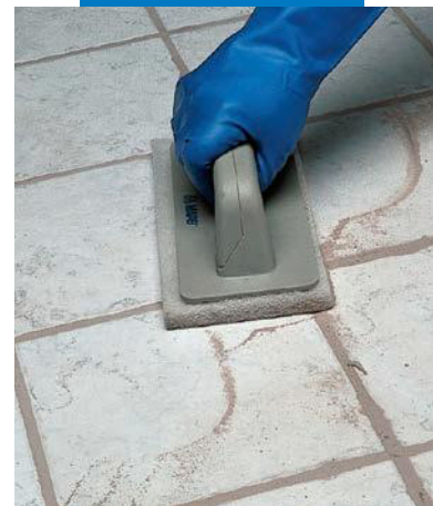
Reinigung mit einem Scotch-Brite® Schwamm
