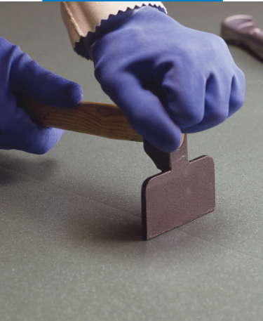
Anreiben des Belages über der Fuge
