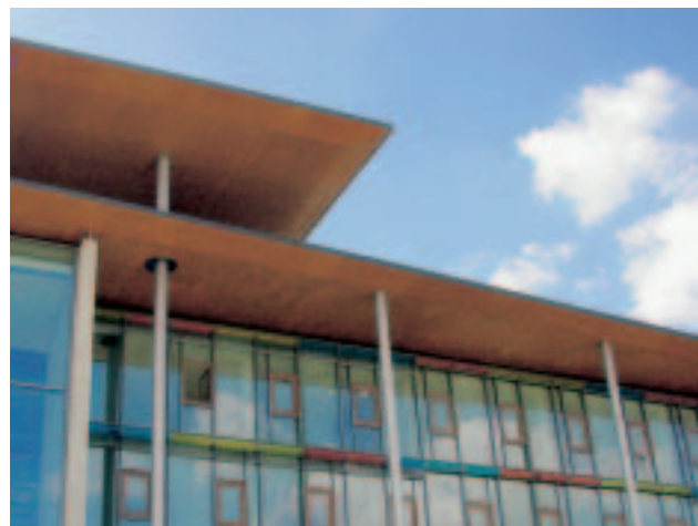
Große Auskragungen in zwei Richtungen, wie hier bei dieser schlanken Dachkonstruktion in München, machen sich die besonderen statischen Fähigkeiten von Kerto® zunutze.
