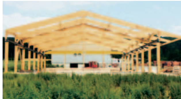
Kerto®-Systemhalle mit Kranbahn und Satteldach in Lienen
