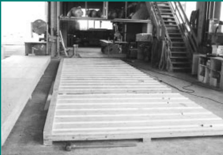
1 Die Herstellung erfolgt auf Arbeitsbühnen in einer Zimmerhalle.
