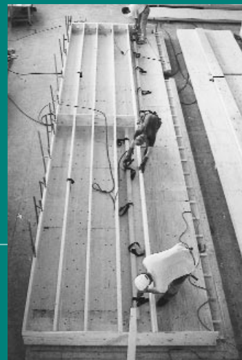
2 Auf die Rippen wird Leim aufgetragen und die Rippen werden gestellt.
