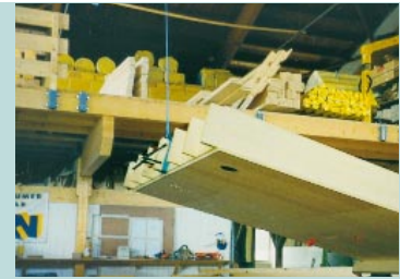
Werkseitige Vorfertigung in geeigneten Holzbaubetrieben
