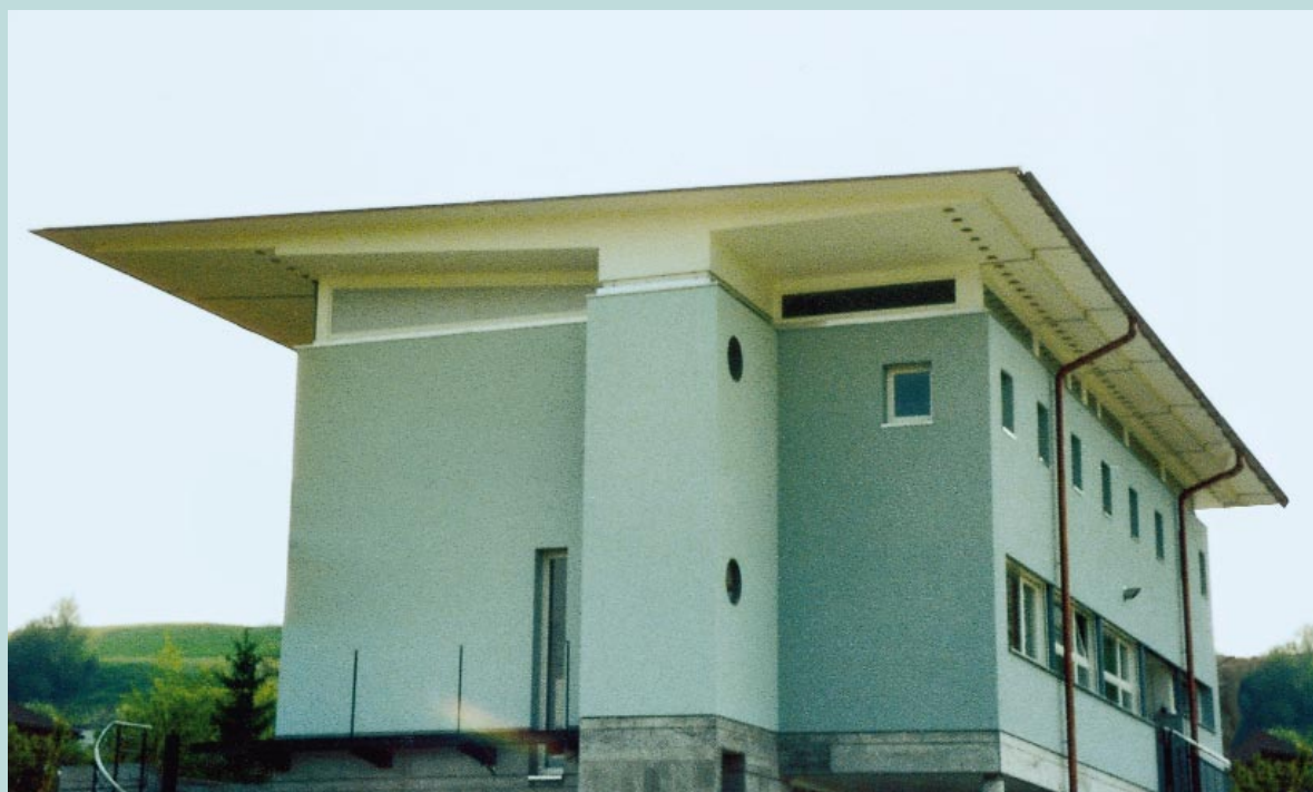
Erweiterung Schreinerei, 9053 Teufen Dachelemente aus Hohlkasten
