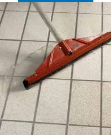
Überschüssiges Waschwasser wird mit einem Gummischieber abgezogen
