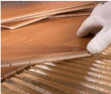
Verlegung von kleinformatischen Mehrschichtparkett
