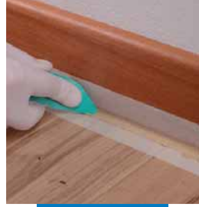
Glattstreichen der Fuge
