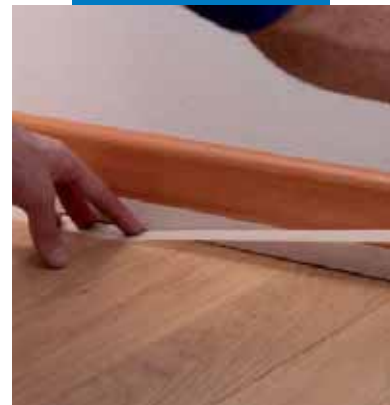
Abkleben der Fuge mit Kreppband
