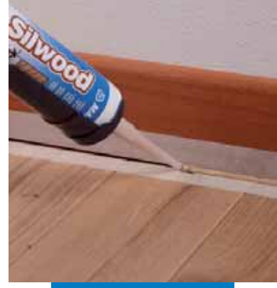
Füllen der Fuge
