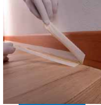
Entfernen des Kreppbandes
