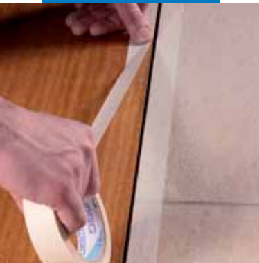
Abkleben der Fuge mit Kreppband
