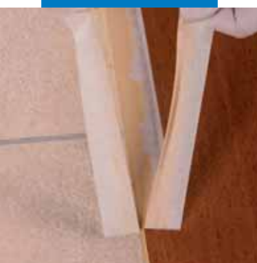
Entfernen des Kreppbandes
