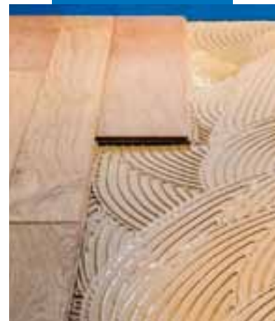
Verlegung von Parkett
