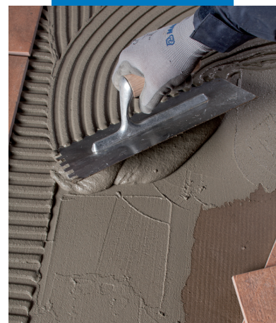
Verlegung der Fliesen mit Elastorapid
