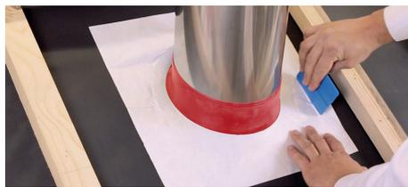
**Manschette zur schnellen und dauerhaften Abdichtung von Durchdringungen mit Temperaturen bis + 250 °C.**
