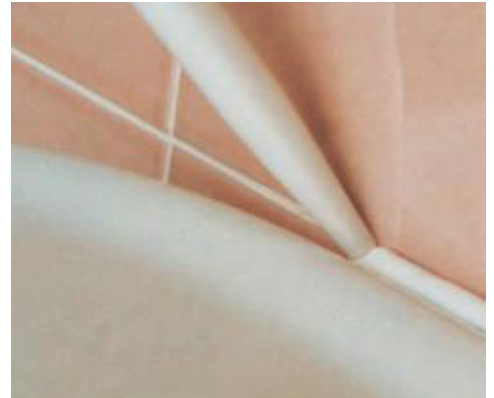
Verfüllen mit Mapesil AC im Sanitärbereich
