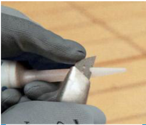
Abschneiden der Kartuschenspitze entsprechend der Fugengröße
