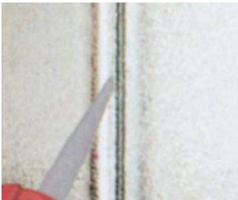
Verfüllen von Glasscheiben mit U-Profil
