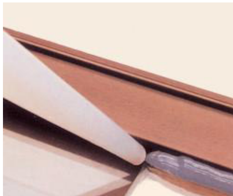
Verfüllen der Fuge eines Aluminiumfensters mit Mapesil AC
