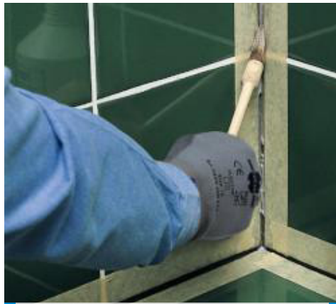
Auftragen von Primer FD
