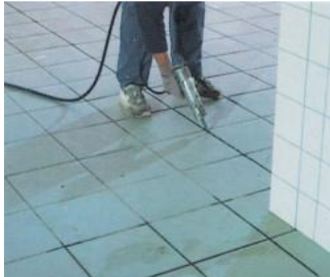
Verfüllung von Dehnungsfugen im Keramikbelag
