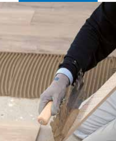
Aufziehen des Klebemörtels im Buttering-Floating-Verfahren
