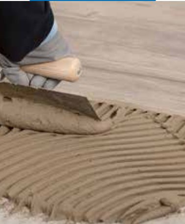
Verlegung von Feinsteinzeugfliesen mit Holzoptik
