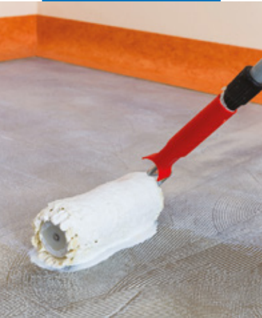
Auftragen von Eco Prim T mit einer Rolle
