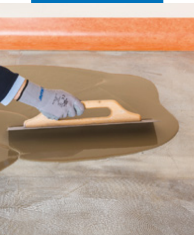
Verteilen von Ultraplan Fast Track mit einem Spachtel
