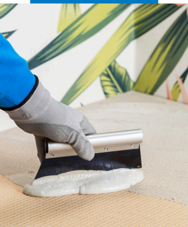
Auftrag von Ultrabond Eco TX3 auf der Dämmunterlage
