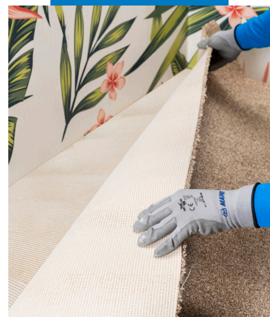
Verlegung eines Teppichbodens auf der Dämmunterlage (Kontaktklebung)
