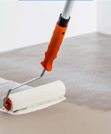
Auftrag von Ultrabond Eco Tack TX+ zur Fixierung einer Dämmunterlage
