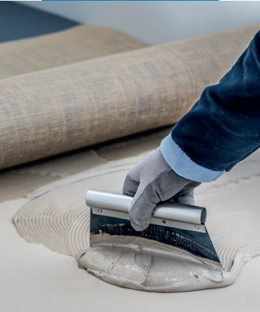
Auftrag von Ultrabond Eco TX3 zur Verlegung von Linoleum
