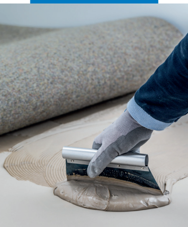
Auftrag von Ultrabond Eco TX3 zur Verlegung von Nadelvlies
