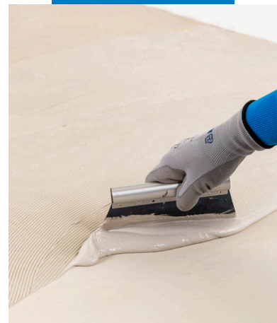
Auftrag von Ultrabond Eco TX3 auf einer Spachtelmasse (Direktklebung)
