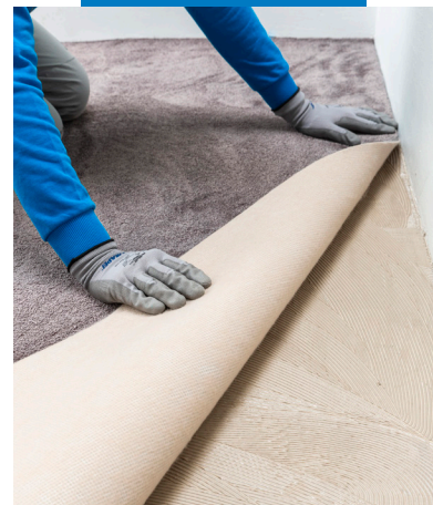
Verlegung eines Teppichbodens mit Action-Bac®
