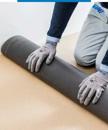
Verlegung einer Dämmunterlage
