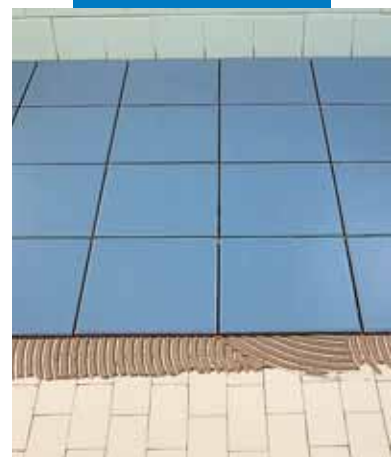
Verlegung "Fliese auf Fliese" mit Keraflex grau
