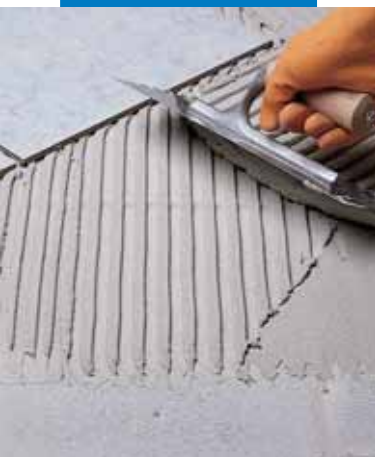
Verlegung von poliertem Marmor mit Keraflex weiss
