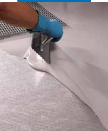
Zweite Schicht Monolastic auf Mape-tex Sel
