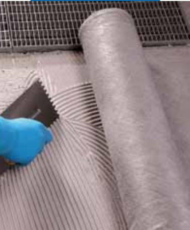
Zweite Schicht Monolastic auf Mape-tex Sel
