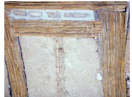
Rohrgewebe St70 auf Holzbalken einer Fachwerkwand
