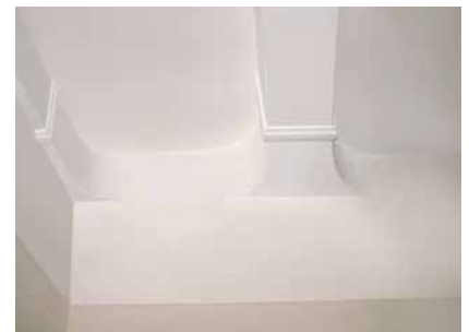
Decke mit umputzten Balken, ausgerundeten Kehlen und Stuckprofilen
