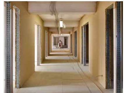
Lehm-Dünnlagen Beschichtung beim BV UN-Campus, Bonn
