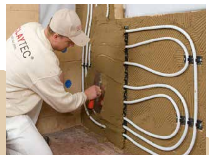
Der Unterputz wird über die Rohrscheitel abgezogen
