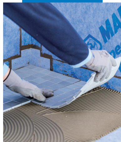
Verlegung von keramischen Fliesen
