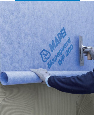
Verlegung von Mapeguard WP 200
