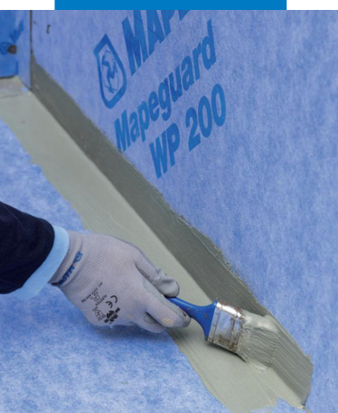
Auftragen des Klebstoffs Mapeguard WP Adhesive im Wand-Boden-Bereich vor dem Aufbringen des Dichtbandes Mapeguard ST
