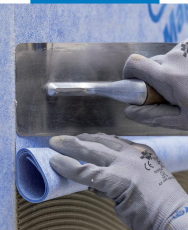
Aufbringen der anschließenden Bahn
