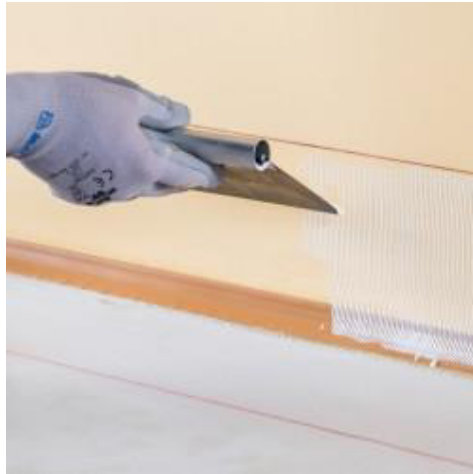
Verlegung eines Hohlkehl-Sockels und Belag mit Ultrabond Eco Fast Track
