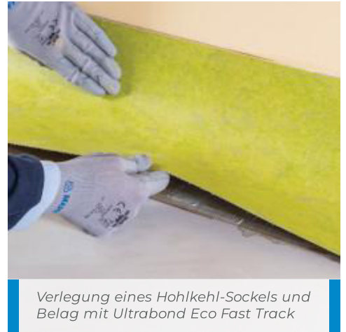
Schnelle Sanierung eines Kautschukbelages mit Ultrabond Eco Fast Track
