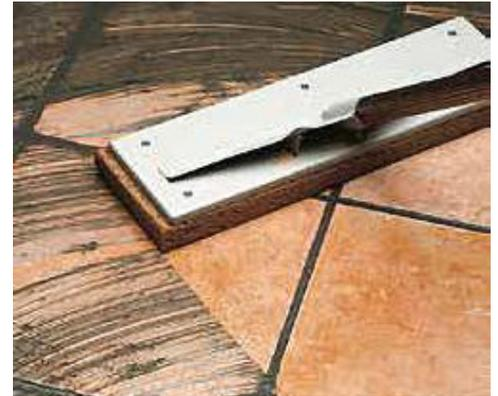
Reinigung eines Bodenbelages mit einem Schwammbrett
