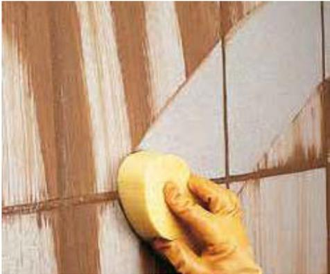
Reinigen des Wandbelages mit einem Schwamm
