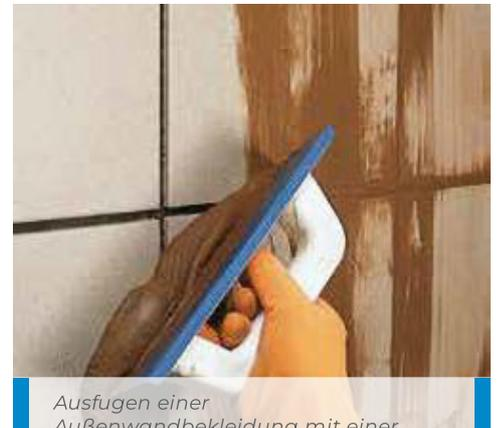
Ausfugen einer Außenwandbekleidung mit einer Fugscheibe
