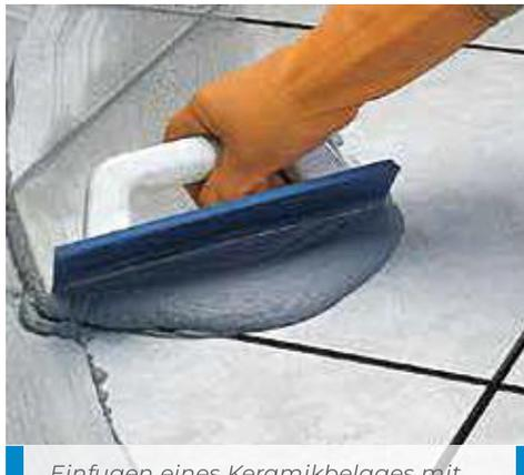
Einfugen eines Keramikbelages mit einer Gummifugscheibe
