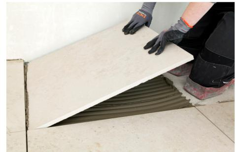
Mit PCI Carrament<sup>®</sup> grau können Naturwerksteinbeläge sicher im Mittelbettverfahren verlegt werden.
